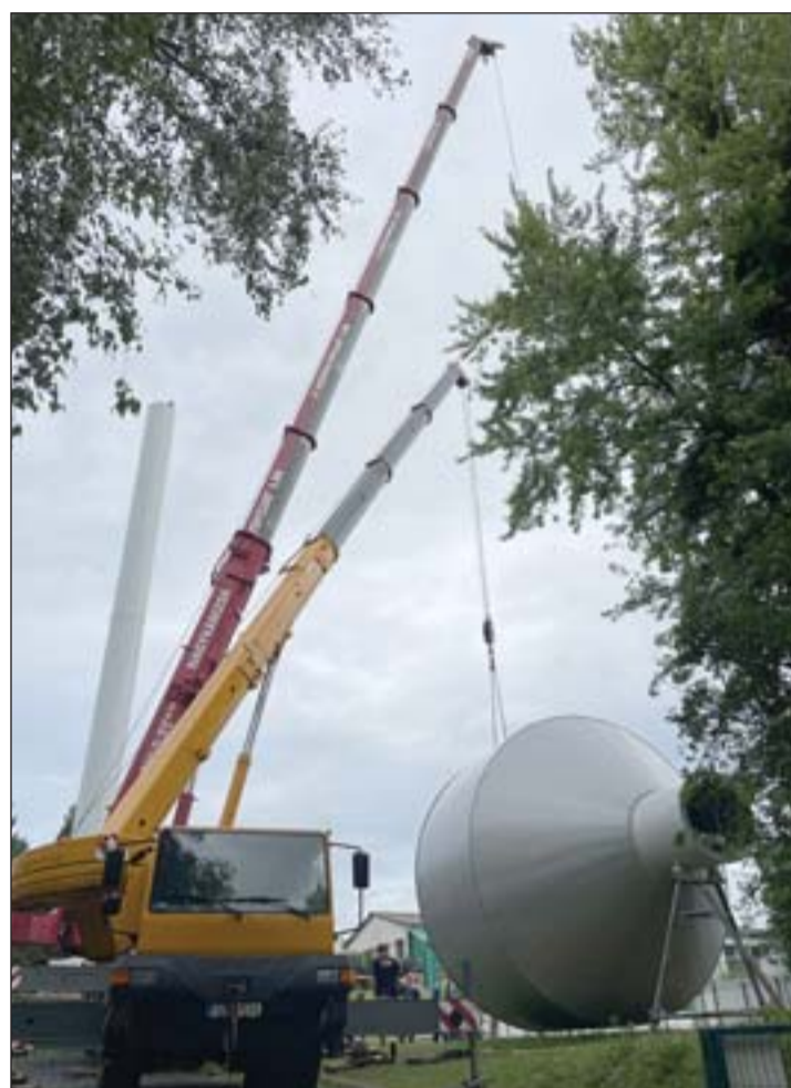
A páterdombi víztorony építése.
