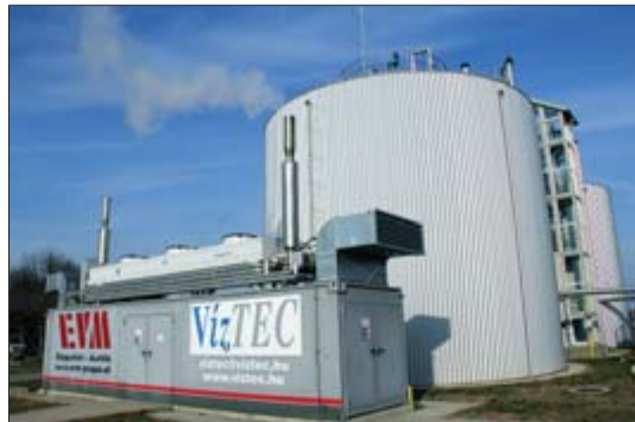
A zalaegerszegi szennyvíztisztító iszapprothasztó torony.
